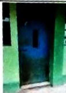
Mantenimiento correctivo de puertas metálica con pintura y daños existentes
