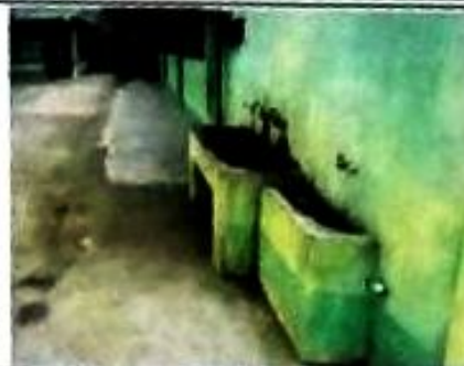
Sustitución de tubería pvc 2" para red de drenaje en lavatrastos, lavamanos y pileta
