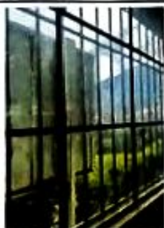
Mantenimiento preventivo de pintura en estructura de ventanas metálicas
