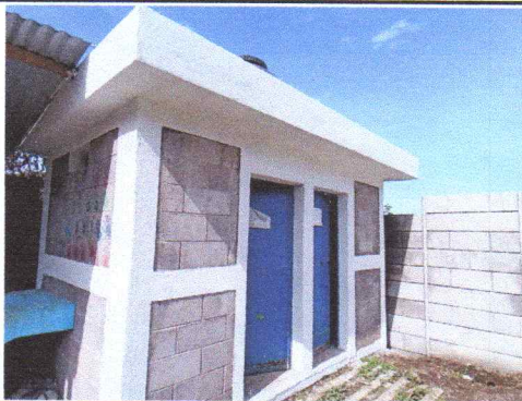
Mantenimiento de pared. Repello y acabados
