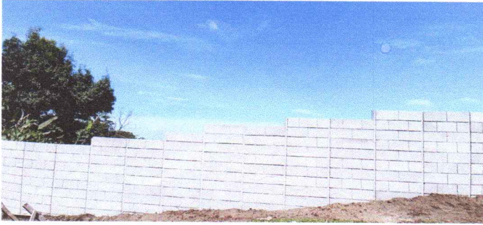
Mantenimiento correctivo con sustitución de postes de concreto de cerco perimetral por barda perimetral de postes y placas de concreto prefabricado.
