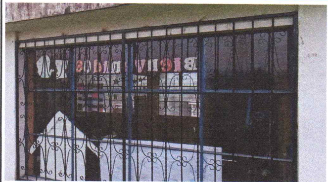
Mantenimiento correctivo por sustitución de balcones
