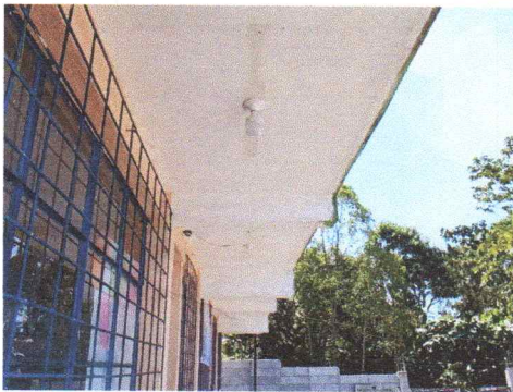
Mantenimiento correctivo con sustitución de focos por focos de luz led 45 wats
