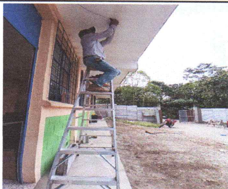
Mantenimiento correctivo con sustitución de focos por focos de luz led 45 wats
