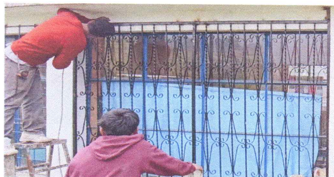
Mantenimiento correctivo por sustitución de balcones
