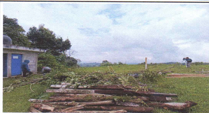
Mantenimiento correctivo con sustitución de postes de concreto de cerco perimetral por barda perimetral de postes y placas de concreto prefabricado.
