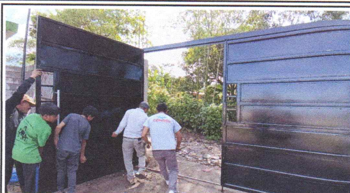
Mantenimiento correctivo con sustitución de láminas galvanizado de portón por portón metálico
