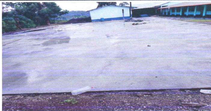
No.1 Sustitución de piso de tierra por pavimento de concreto en Cancha Polideportiva 500 mts
