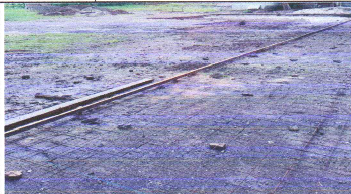
No.1 Sustitución de piso de tierra por pavimento de concreto en Cancha Polideportiva 500 mts
