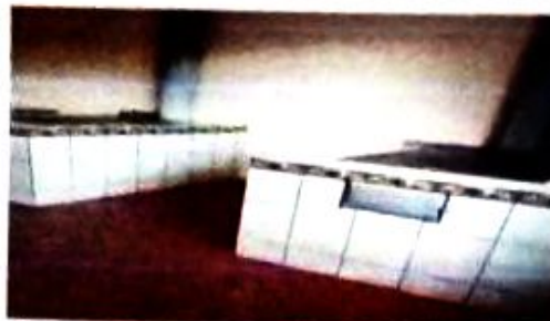
Foto 2: sustitución de estufa rural de concreto y ladrillo, con plancha metálica doblemente reforzada
