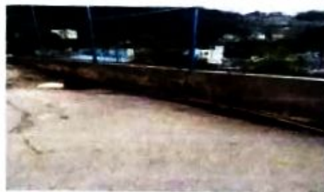
Foto 14: mantenimiento preventivo de pared con solera de concreto armado de 15x20
