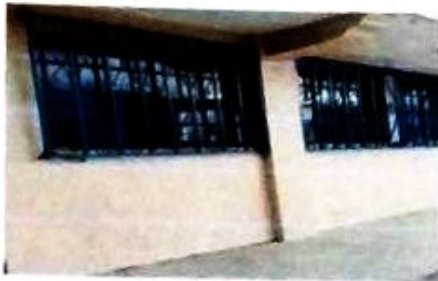
Foto 9: mantenimiento de baranda de ventana con pintura anticorrosiva
