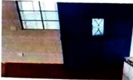
Foto 7: Mantenimiento correctivo de puertas de metal, limpieza, corte, aplicación de pintura.
