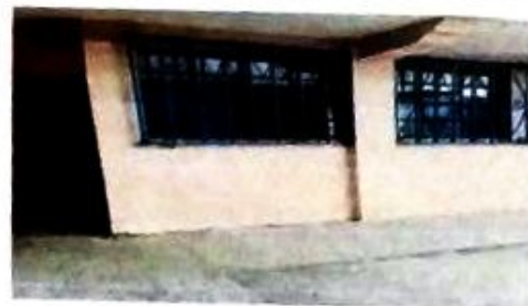
Foto 12: mantenimiento correctivo en pared con pintura acrílica interior y exterior
