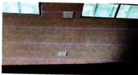
Foto 11: sustitución de tomacorrientes de doble toma incluye poliducto y cable c12.
