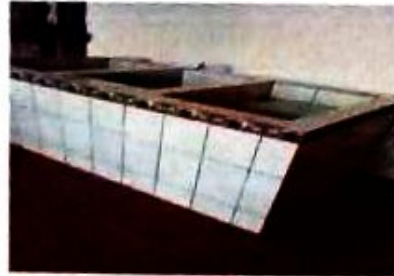
Foto 8: sustitución de pila de concreto con dos lavaderos + depósito de agua + azulejo interior y exterior.
