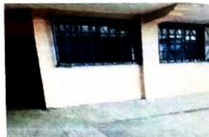
Mantenimiento correctivo en pared con pintura acrílica interior y exterior
