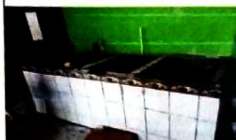
Foto 8: sustitución de pila de concreto con dos lavaderos + depósito de agua + azulejo interior y exterior
