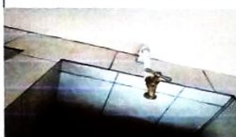
Foto 4: sustitución de línea de agua potable con tubería de 1/2 corte de piso, accesorio y llaves.
