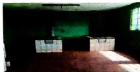
Foto 10: sustitución de bombillas led 50 w incluye interruptor
