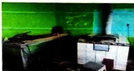
Foto 5: sustitución de mesa de concreto+ top de cocina laminado+ azulejo interior y exterior
