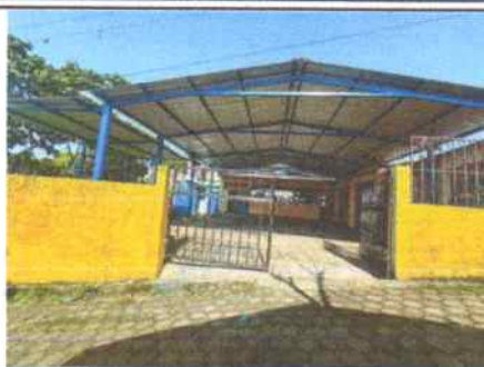
Sustitución de estructura metálica para techo
