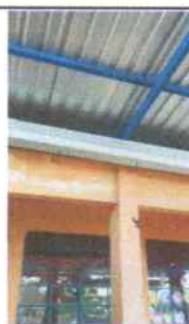
Sustitución de canaleta para drenaje pluvial
