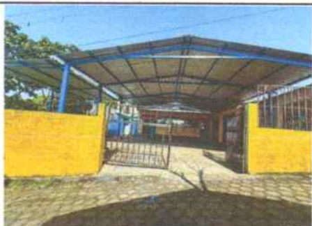
Sustitución de cubierta con lamina troquelada C26 incluye capote
