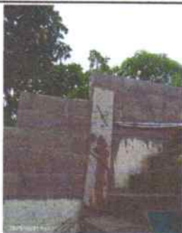
Mantenimiento correctivo de muro con block de 19x19x39
