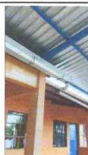
Sustitución de canaleta para drenaje pluvial
