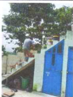
Mantenimiento correctivo de muro con block de 19x19x39
