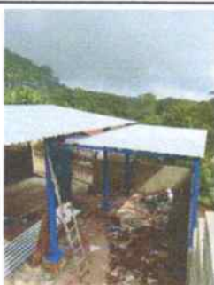
Sustitución de cubierta con lamina troquelada C26 incluye capote
