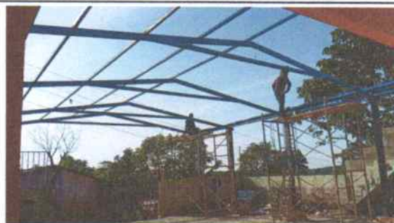
Sustitución de estructura metálica para techo
