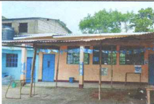
Sustitución de cubierta con lamina troquelada C26 incluye capote
