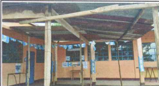
Sustitución de estructura metálica para techo
