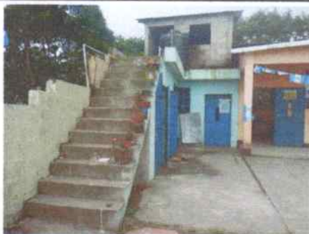
Mantenimiento correctivo de muro con block de 19x19x39
