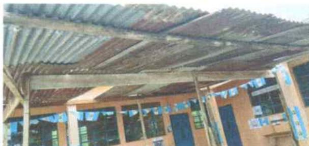
Sustitución de canaleta para drenaje pluvial
