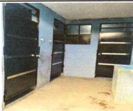
No.5 SUSTITUCIÓN DE PUERTAS METALICAS DE BAÑO 2.23x0.81 MTS
