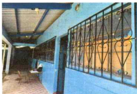
No.9 MANTENIMIENTO DE BALCONES (LIJADO, SUJECIONES Y APLICACIÓN DE PINTURA)
