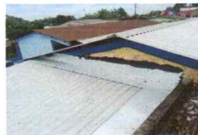
No. 12. MANTENIMIENTO CORRECTIVO CUMBRERA DE TECHO SOBRE COCINA CON LAMINA LISA Y SELLADO CON SELLADOR SIKAFLEX POLIURETANO
