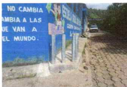
No. 11. MANTENIMIENTO CORRECTIVO BANQUETA Y COLOCACION DE POSTES DE PROTECCIÓN CON TUBO PROCESO DE 4"
