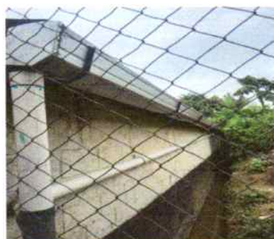
No.2 MANTENIMIENTO CORRECTIVO CON SUSTITUCIÓN DE CANAL
