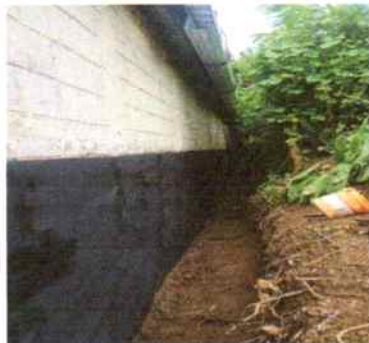
No.1 SUSTITUCIÓN DE REPELLO SOCALO EN PARED EXTERIO DE AULAS POR REPELLO ALIZADO CON ADITIVO
