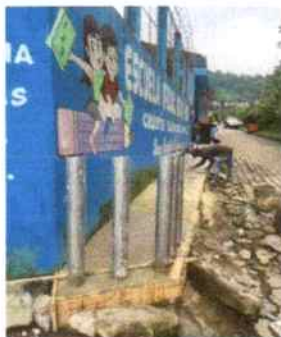
NO.11 MANTENIMIENTO CORRECTIVO BANQUETA Y COLOCACION DE POSTES DE PROTECCIÓN CON TUBO PROCESO DE 4"
