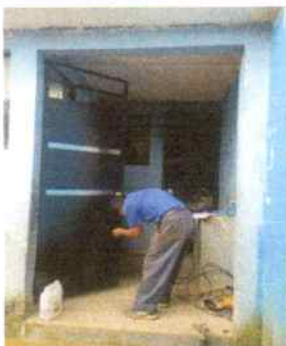
No.5 SUSTITUCIÓN DE PUERTAS METALICAS DE BAÑO 2.23x0.81 MTS
