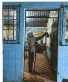
No. 10 MANTENIMIENTO DE PUERTAS METALICAS (LIJADO, SUJECIONES Y APLICACIÓN DE PINTURA)
