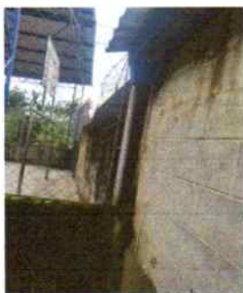
No.3 REPARACIÓN Y CONEXIÓN DE BAJADAS DE AGUA PLUVIAL PARA 3 AULAS Y COCINA
