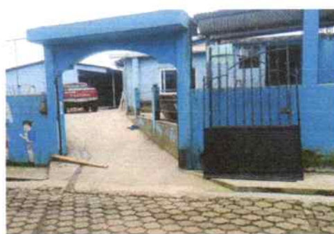
No.8 SUSTITUCION DE PORTÓN METÁL TIPO REJAS DE INGRESO PRINCIPAL DE 3.00X2.70 POR PORTÓN METÁL
