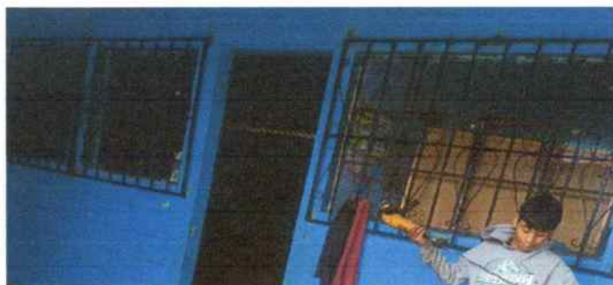
No.9 MANTENIMIENTO DE BALCONES (LIJADO, SUJECIONES Y APLICACIÓN DE PINTURA)
