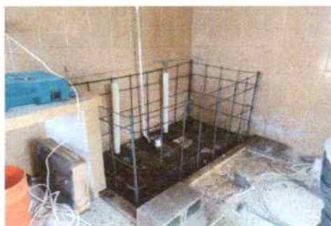
No.7 SUSTITUCIÓN DE PILA MOVIBLE POR PILA DE CONCRETO ARMADO CON RECUBRIMIENTO
