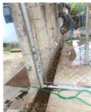
No.4 SUSTITUCION DE TUBERIA PVC DE LINEA PRINCIPAL DE AGUAS PLUVIALES DE 3"
