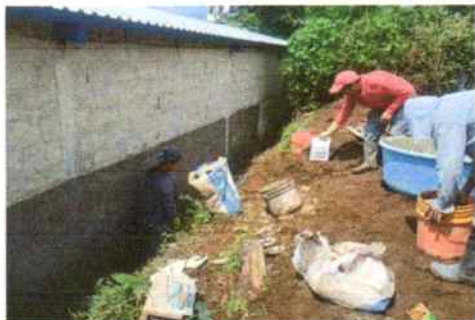
No.1 SUSTITUCIÓN DE REPELLO SOCALO EN PARED EXTERIO DE AULAS POR REPELLO ALIZADO CON ADITIVO
