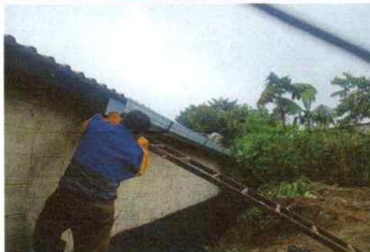
No.2 MANTENIMIENTO CORRECTIVO CON SUSTITUCIÓN DE CANAL
