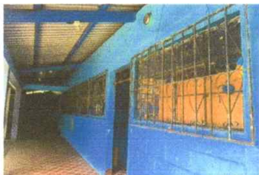
No.9 MANTENIMIENTO DE BALCONES (LIJADO, SUJECIONES Y APLICACIÓN DE PINTURA)
