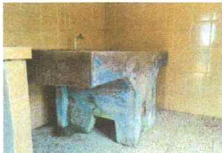
No.7 SUSTITUCIÓN DE PILA MOVIBLE POR PILA DE CONCRETO ARMADO CON RECUBRIMIENTO
