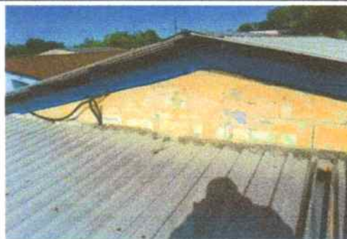
MANTENIMIENTO CORRECTIVO CUMBRERA DE TECHO SOBRE COCINA CON LAMINA LISA Y SELLADO CON SELLADOR SIKAFLEX POLIURETANO
