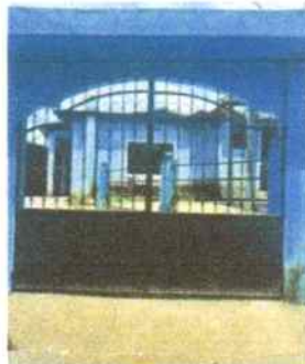
No.8 SUSTITUCIÓN DE PORTÓN METÁL TIPO REJAS DE INGRESO PRINCIPAL DE 3.00X2.70 POR PORTÓN METÁL
