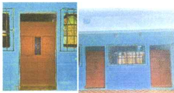
No. 10 MANTENIMIENTO DE PUERTAS METÁLICAS (LIJADO, SUJECIONES Y APLICACIÓN DE PINTURA)
