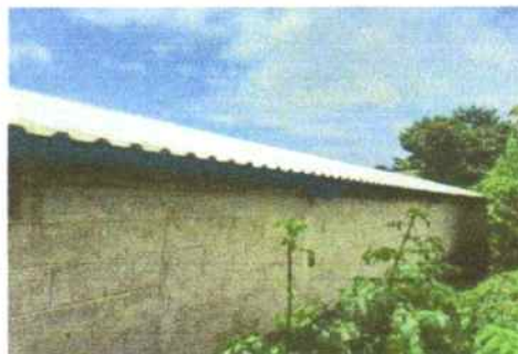
No.2 MANTENIMIENTO CORRECTIVO CON SUSTITUCIÓN DE CANAL
