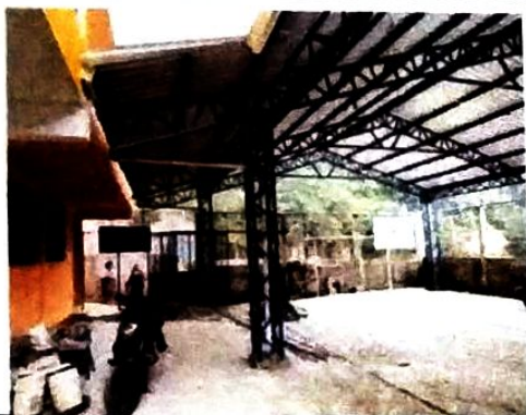
Foto 3: Mantenimiento para canal pluvial + limpieza realizada
