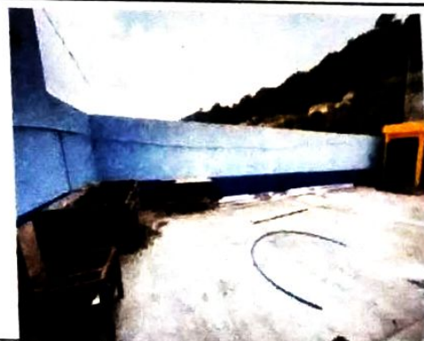
Foto 4: Aplicación de pintura interior y exterior
