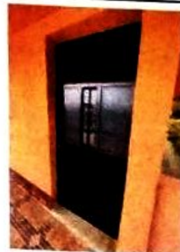
Foto 4: Puerta metálica en direccion instalada
