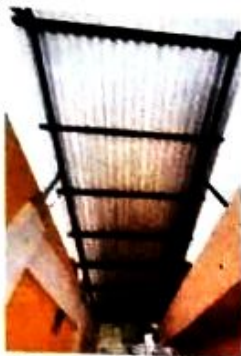
Foto 1: estructura portante metálica con cubierta de lamina
