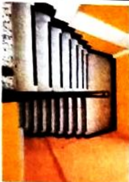
Foto 3: Cinta antideslizante para gradas instalada
