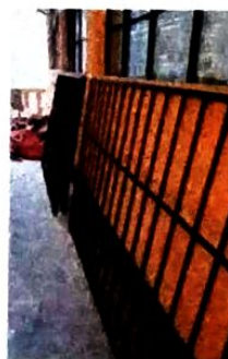
Foto 6: Instalación de balcones metálicos
