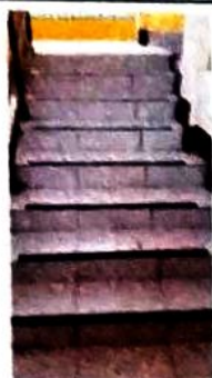
Foto 3: Fijación de cinta antideslizante en gradas
