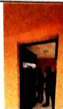
Foto 4: Instalación de puerta metálica en el área de dirección
