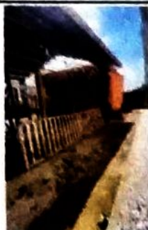
Foto 5: desinstalación de baranda de madera
