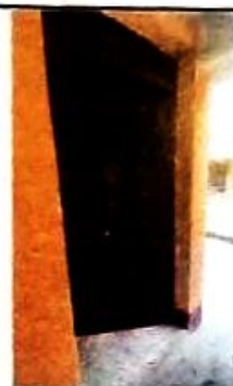
Sustitución de puerta metálica (puerta + vidriera superior)
