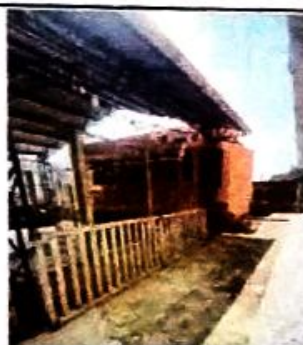
Sustitución de baranda de madera por baranda metálica en rampa
