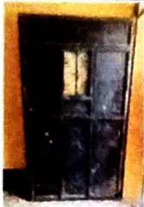
Mantenimiento correctivo de puertas metálicas con pintura y daños existentes
