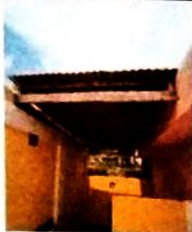
Sustitución de cubierta de lamina por lamina troquelada cal. 26, Sustitución de estructura portante de madera por estructura metálica
