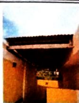
Sustitución de cubierta de lamina por lamina troquelada cal. 26
