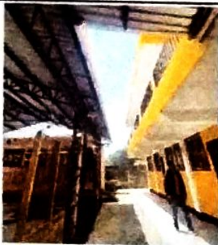
Mantenimiento correctivo de canal pluvial en techo de cancha (se tomo en consideración la altura a trabajar)
