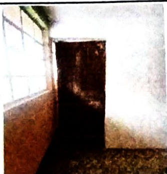
sustitución de puertas de madera por puertas de HDF
