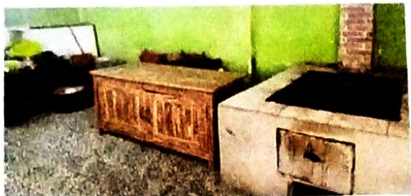
Sustitución de puertas de madera en mesa de trabajo de cocina
