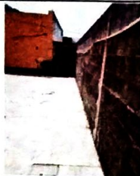
Mantenimiento preventivo de pintura en muros interiores y exteriores
