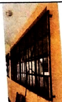
Sustitución de balcones metálicos en ventanas
