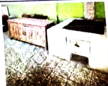
Sustitución de azulejo en mesa de trabajo y muro
