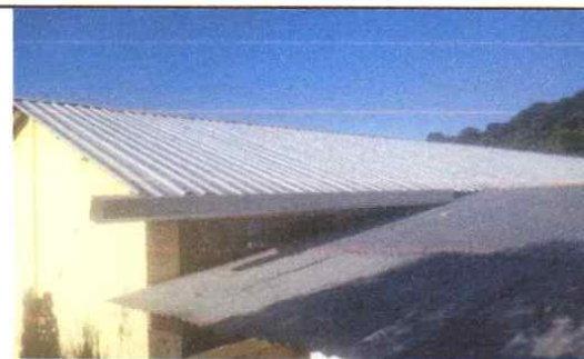
33 metros lineales de Mantenimiento correctivo de techo con canaletas para agua pluvial
