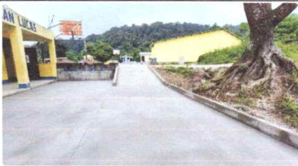
18 metros cúbicos de Mantenimiento correctivo de patio con concreto 3000PSI
