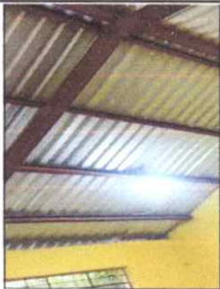
15 unidades de Sustitución de bombillas led + plafonera
