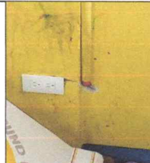
6 unidades de Sustitución de tomacorriente doble contacto
