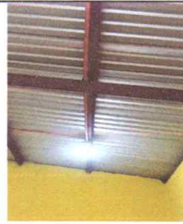
77 metros lineales de Mantenimiento correctivo de sistema eléctrico con cable 12 (línea de iluminación y línea de fuerza) + incluye flexitubo + abrazaderas metálicas
