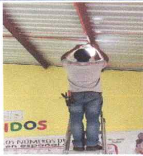
15 unidades de Sustitución de bombillas led + plafonera
