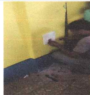
6 unidades de Sustitución de tomacorriente doble contacto
