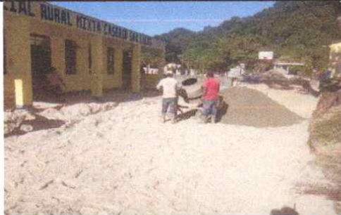
18 metros cúbicos de Mantenimiento correctivo de patio con concreto 3000PSI
