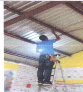
77 metros lineales de Mantenimiento correctivo de sistema eléctrico con cable 12 (línea de iluminación y línea de fuerza) + incluye flexitubo + abrazaderas metálicas
