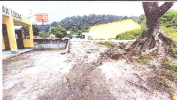
Mantenimiento correctivo de patio con concreto 3000PSI
