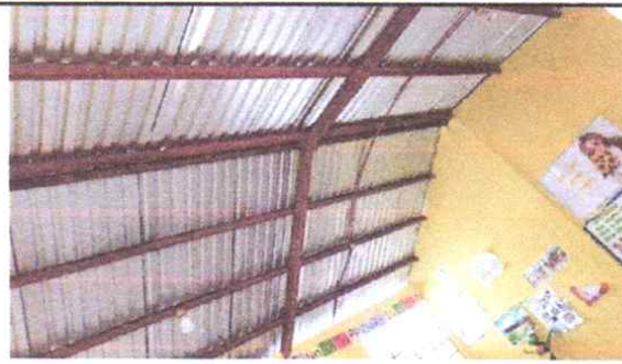
Mantenimiento correctivo de sistema eléctrico con cable 12 (línea de iluminación y línea de fuerza) + incluye flexitubo + abrazaderas metálicas
