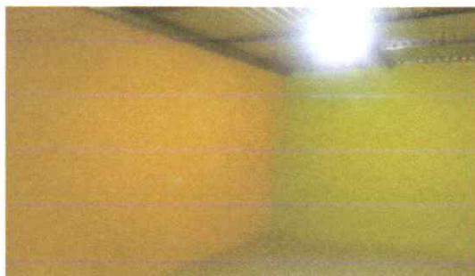
mantenimiento preventivo de muro con pintura acrilica. 140 m.
