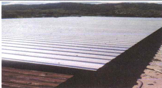
sustitución de techo con lamina troquelada C26 recubierta de aluminio y zinc (incluye canales para bajada de agua) 72 unidades.
