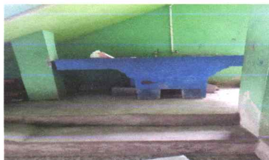
Mantenimiento correctivo de sistema de drenaje con fundición de concreto
