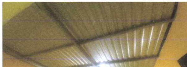
sustitución de estructura metalica para techo con tubo 1.5mm y tubo estructural GHT 1,5mm 72 unidades
