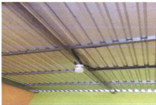
Sustitución de Instalación eléctrica de iluminación y fuerza (incluye cable c12, tomacorrientes, plafoneras, bombillas, flexitubo y canaletas)
