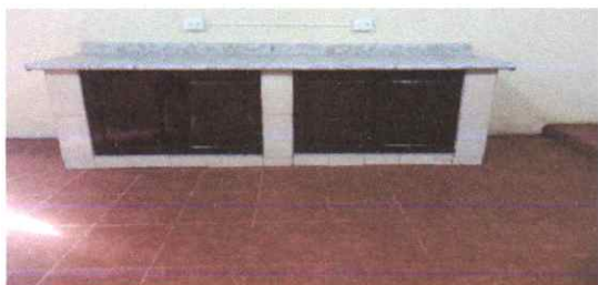
sustitución de mesa de concreto más azulejo 2.8m
