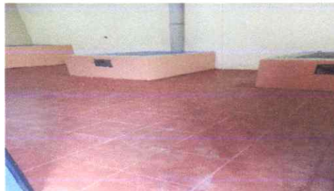
sustitución de base para piso con mortero (incluye levantado de mortero actual) 56m
