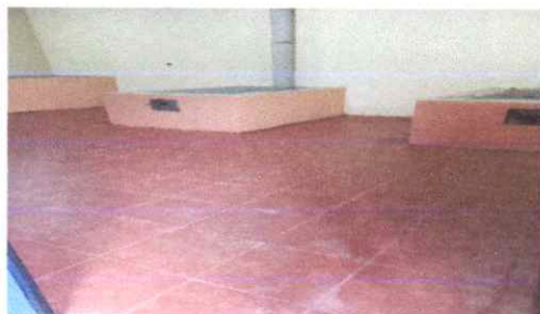
mantenimiento de piso con ceramica antideslizante 66m.
