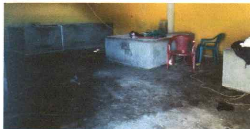
sustitución de base para piso con mortero (incluye levantado de mortero actual) 56m.
