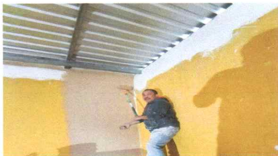
mantenimiento preventivo de muro con pintura acrilica. 140m.
