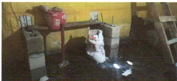
sustitucion de mesa de concreto más azulejo 2.8m
