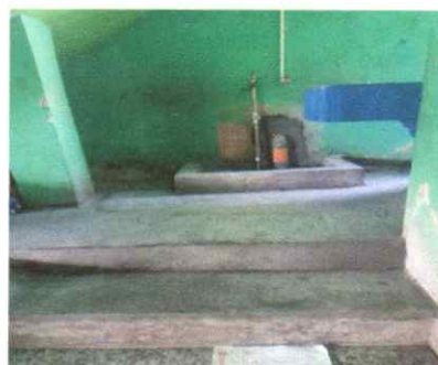
mantenimiento correctivo del sistema de drenaje con fundición de concreto.
