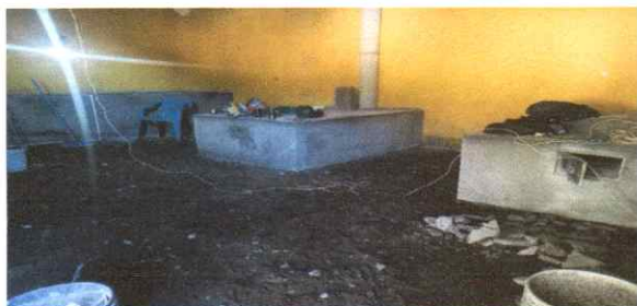
mantenimiento de piso con ceramica antideslizante 66m
