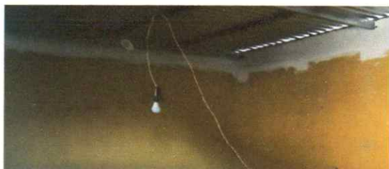
sustitución de instalación electrica de iluminación y fuerza (incluye cable C12, tomacorrientes, plafoneras bombillas, flexitubo y canaletas)
