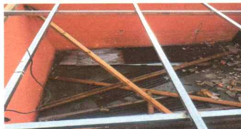
sustitución de estructura metalica para techo con tubo 1.5mm tubo estructural GHT 1.5mm 72 unidades
