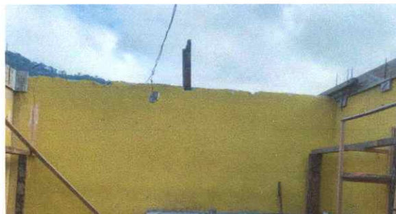
mantenimiento preventivo de muro con solera de amarre de concreto armado de 15x20, 45 metros
