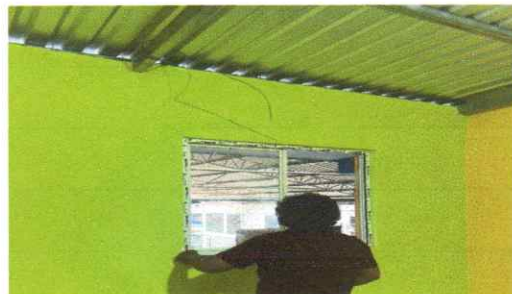
sustitución de ventana con marco de aluminio blanco 1 unidad.
