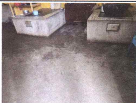
Mantenimiento de piso con ceramica antideslizante
