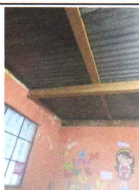
Mantenimiento preventivo de muro con solera de amarre de concreto armado de 15x20
