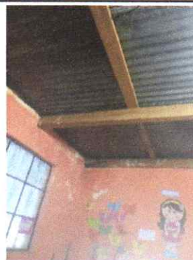
Sustitución estructura metalica para techo con tubo GHT 1.5mm y tubo estructural GHT 1.5mm
