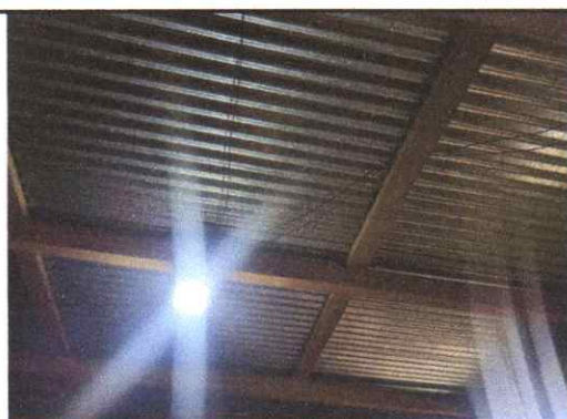
Sustitución de Instalación eléctrica de iluminación y fuerza (incluye cable c12, tomacorrientes, plafoneras, bombillas, flexitubo y canaletas)
