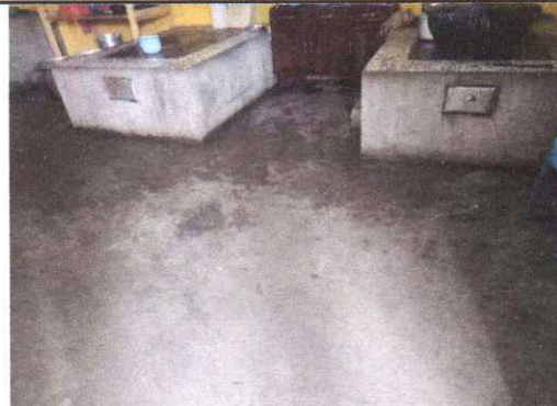
Sustitución de base para piso con mortero (incluye levantado de mortero actual)
