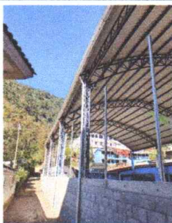
55 metros lineales de Mantenimiento preventivo de pared con solera de 20x20cm + armadura hierro de 3/8
