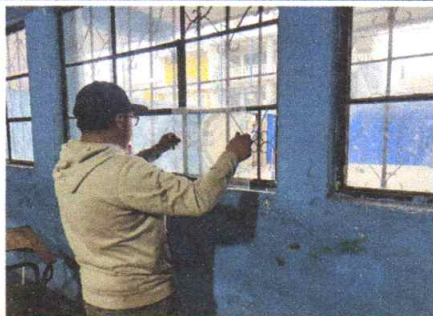
35 unidades de Sustitución de ventanas con vidrio transparente
