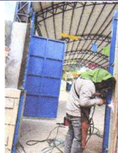
1 unidad de Sustitución de puerta de metal con chapa + pintura anticorrosiva
