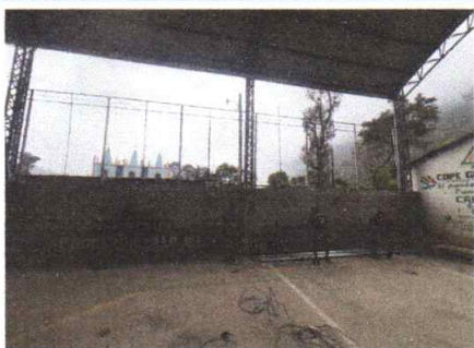
90 metros cuadrados de Sustitución de malla electrosoldada con marco de metal + pintura anticorrosiva + postes de tubo galvanizado
