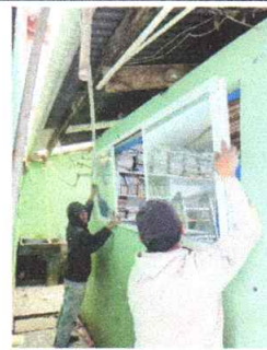
1 unidad Sustitución de ventana con marco de aluminio blanco
