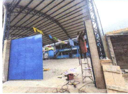
1 unidad de Sustitución de porton de metal de 6.5x3m + pintura anticorrosiva + rieles + soporte de metal
