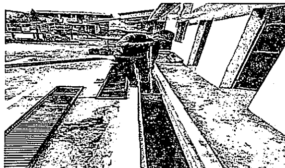
Mantenimiento correctivo de rejillas de drenaje
