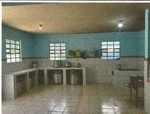
Foto 3: Sustitución de mesa de madera por mesa de concreto con todo el azulejo finalizado.
