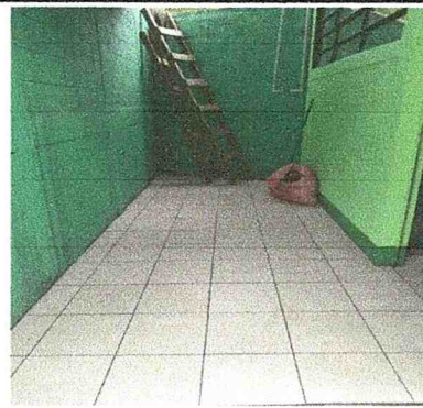
Foto 2: Sustitución de concreto por piso cerámico finalizado.
