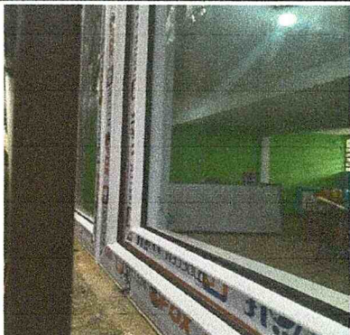
Foto 1: Sustitución de ventana de metal por ventana de pvc color blanco finalizado
