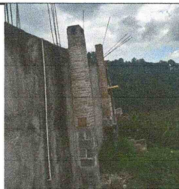
Foto 6: Mantenimiento correctivo de chimenea de metal por ladrillo finalizado.
