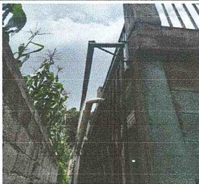
Foto 5: Sustitucion de lamina acanalada y estructura de madera por estructura de metal y lamina troquelada para proteger las ventanas.
