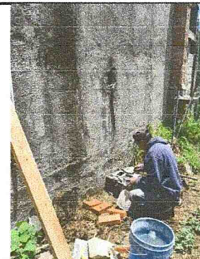
Foto 6: Mantenimiento correctivo de chimenea de metal por ladrillo.
