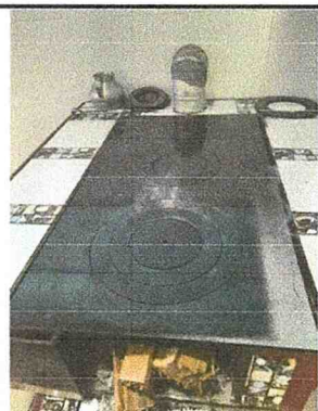
Foto 9: Sustrucción de plancha de metal por plancha de metal en estufa rural en modulo de cocina.
