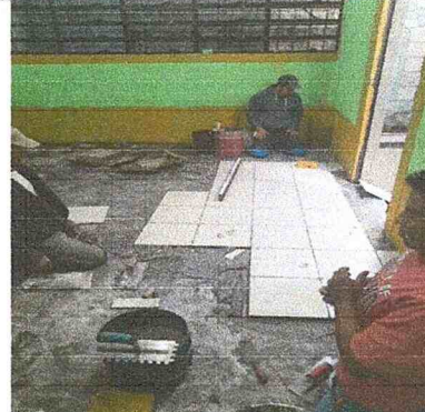
Foto 2: Sustitucion de concreto por piso ceramico durante el proceso.
