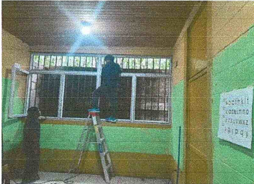
Foto 1: Sustitucion de ventana de metal por ventana de pvc color blanco durante el proceso.
