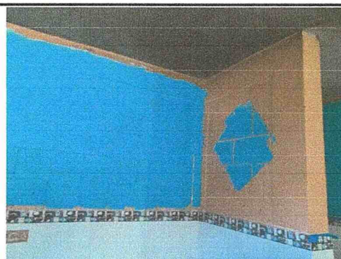
Foto 10: Mantenimiento y aplicación de pintura en pared de block, en modulo de cocina.
