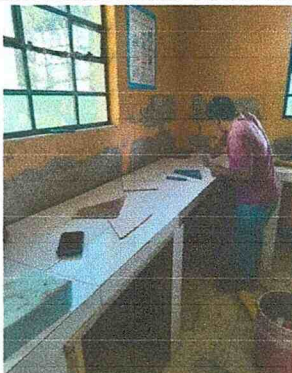
Foto 3: Sustitucion de mesa de madera por mesa de concreto con todo el azulejo durante el proceso.
