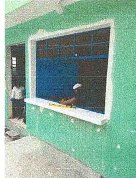
Foto 4: Sustitucion de ventana de metal por ventana de metal para despachar la refaccion de los estudiantes. Durante el proceso.
