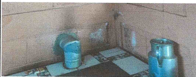
Mantenimiento correctivo en pared por azulejo cerámico cocina
