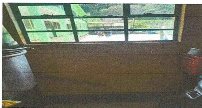
Sustitución de ventana de metal por ventana de metal de tubo de 1", chapa 18, más lámina 13/64"38", cubierta con dos capas de pintura r15
