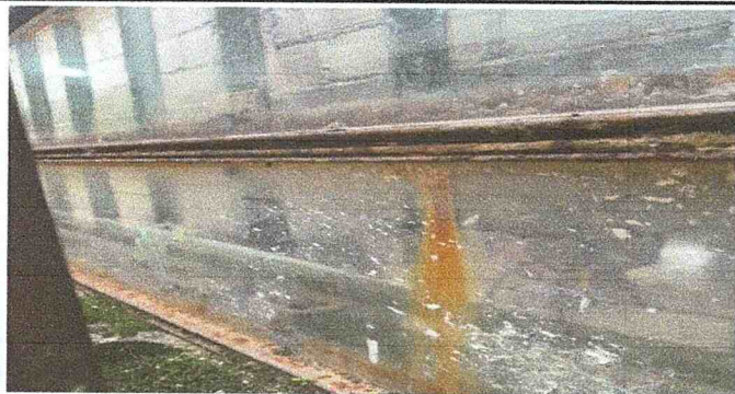
Sustitución de ventana de metal por ventana de PVC color blanco serie 80, OPCM en módulo 1
