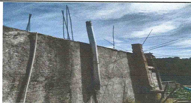
Mantenimiento correctivo de chimenea de metal
