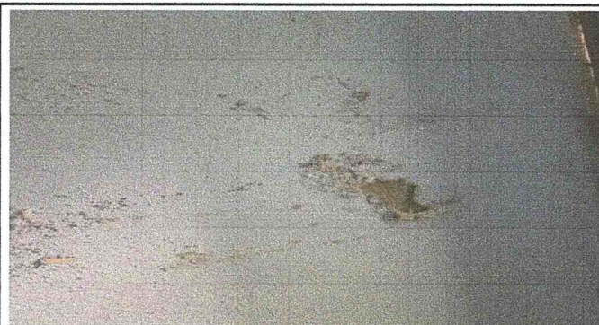
Mantenimiento correctivo en pared por azulejo cerámico en baños
