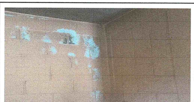
Mantenimiento y aplicación de pintura en pared de block, en modulo de cocina.
