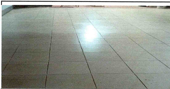
Sustitución de piso, por piso cerámico formato 33.33 cms marca vitromex
