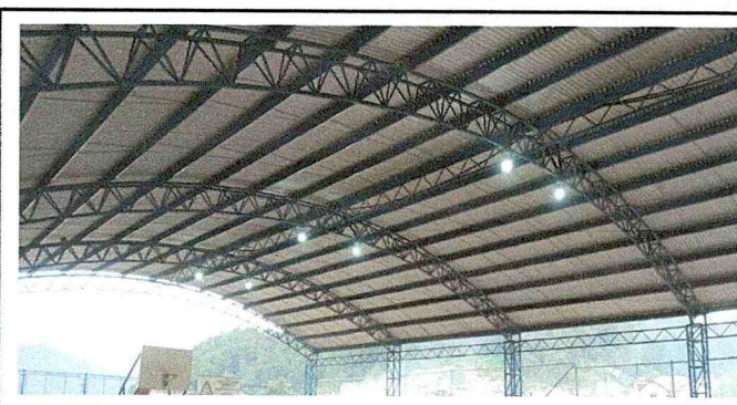
Sustitución de lámparas, por lámparas en cancha deportiva incluye cableado y protección de metal
