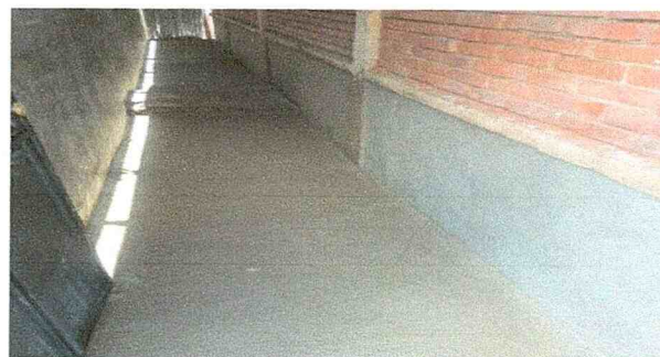
Mantenimiento correctivo en muros con repello impermeabilizante
