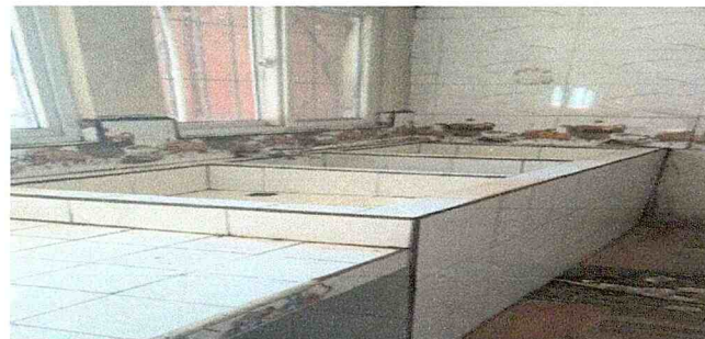
Sustitución de pila de concreto en cocina con tanque de reserva incluye 2 lavaderos y accesorios + azulejos
