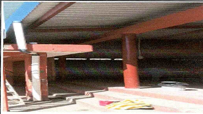
Sustitución de canal por PVC de 2 pulgadas alto flujo en terraza lateral
