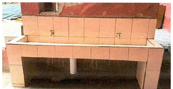
Sustitución de lavamanos por lavamanos empotrados incluye azulejos
