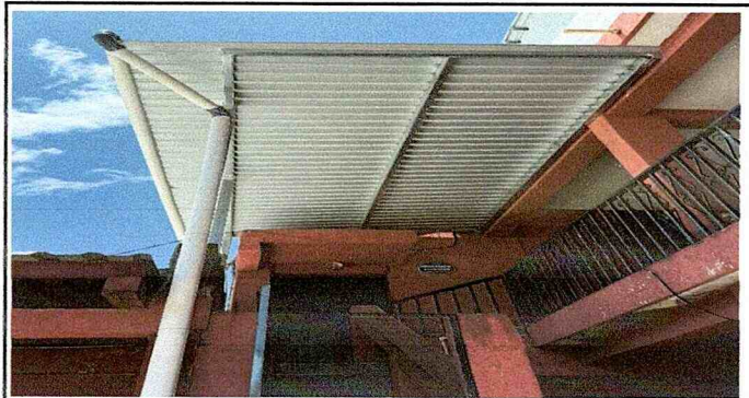
Sustitución de lámina troquelada calibre 26
