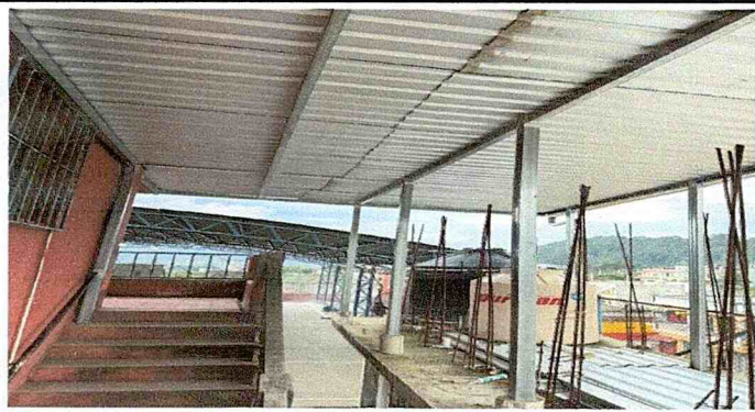
Sustitución en estructura de soporte en baños con material galvanizado
