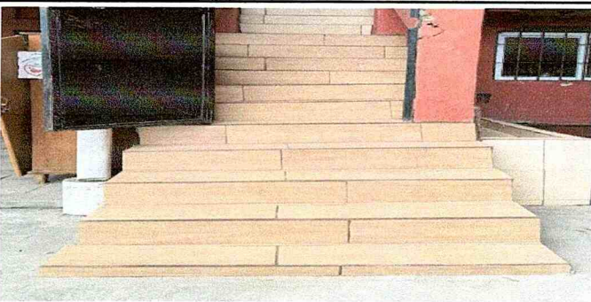
Sustitución de piso de cemento por cerámico en gradas
