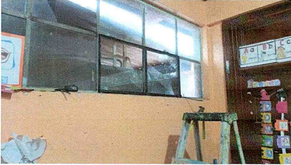
Sustitución de ventana en aula
