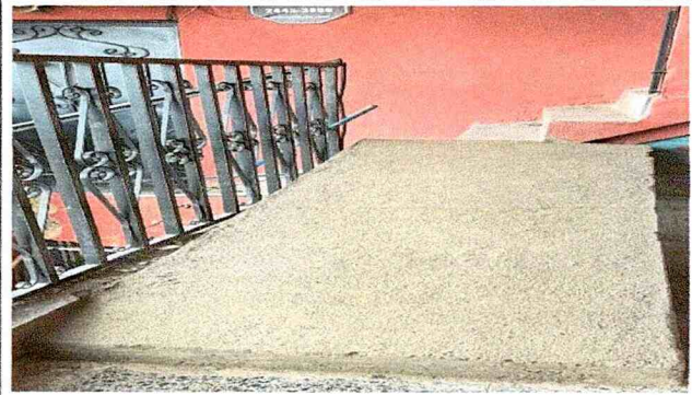
Mantenimiento correctivo a rampa de acceso
