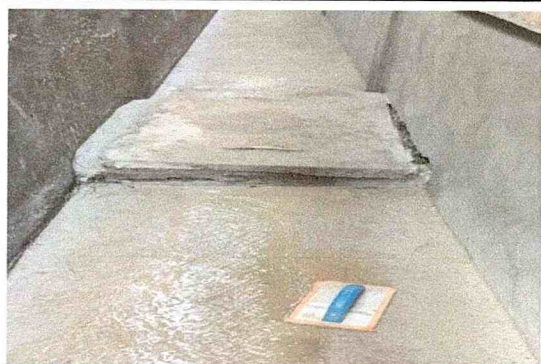
Mantenimiento en piso de concreto en bodega
