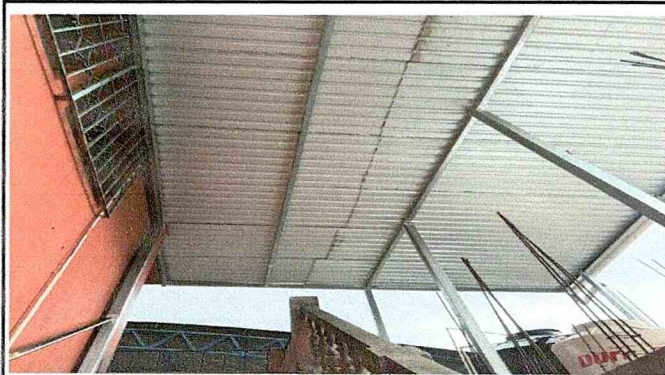
Sustitución de lámina troquelada calibre 26 incluye accesorios
