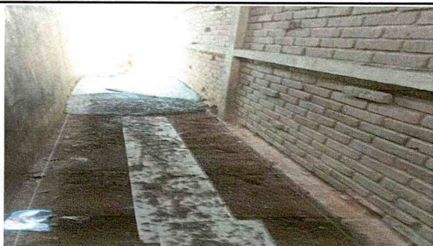
Mantenimiento en piso de concreto en bodega
