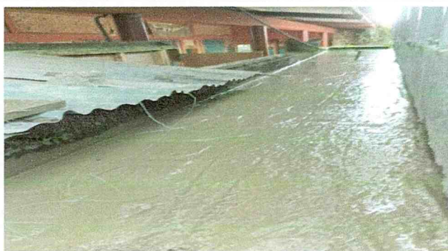
Mantenimiento correctivo en pañuelos en terraza lateral
