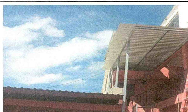
Sustitución de lámina troquelada calibre 26
