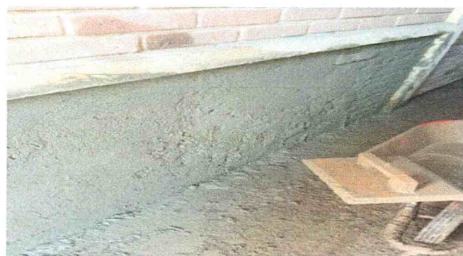
Mantenimiento correctivo en muros con repello impermeabilizante
