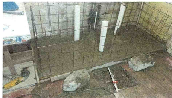
Sustitución de tanque de agua en cocina con tanque incluye 2 lavaderos y accesorios más azulejo
