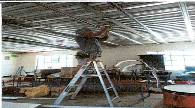
Sustitución de cielo falso por cielo de PVC
