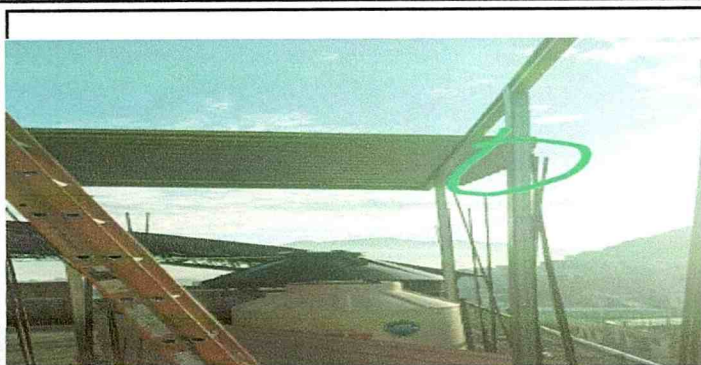
Sustitución en estructura de soporte en baños con material galvanizado
