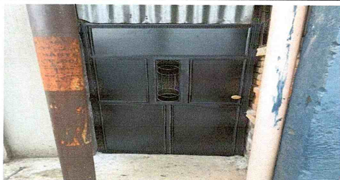
Susitución puerta de metal con chapa yale
