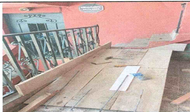
Mantenimiento correctivo a rampa de acceso
