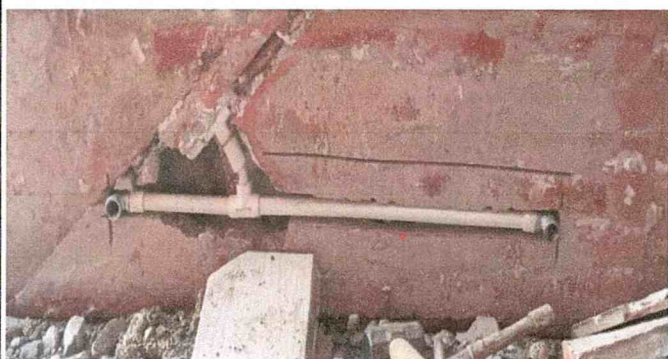
Mantenimiento de tubería de agua 1/2" existente
