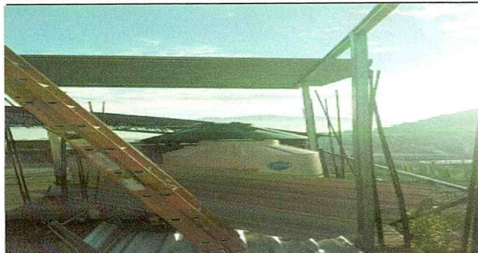
Sustitución de lámina troquelada calibre 26 incluye accesorios
