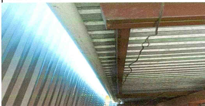
Sustitución de canal de PVC de 2 pulgada alto flujo en terraza lateral
