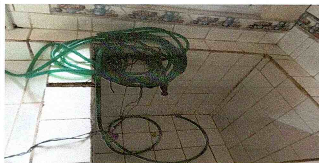
Foto 8: Sustitución de tanque de agua en cocina con tanque incluye 2 lavaderos y accesorios + azulejo
