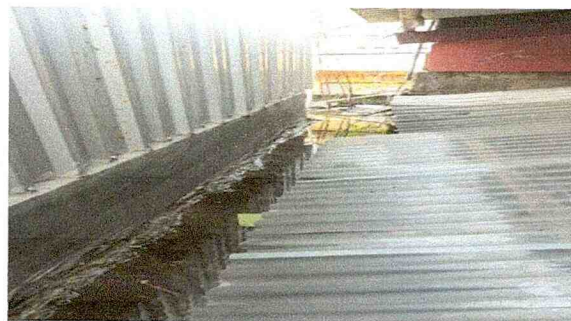
Foto 4: Sustrución de canal de pvc de 2 pulgada alto flujo en terraza lateral
