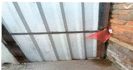
Foto 11: Sustitución puerta de metal con chapa yale
