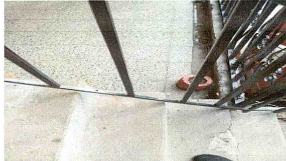
Foto 14: Mantenimiento correctivo a rampa de acceso
