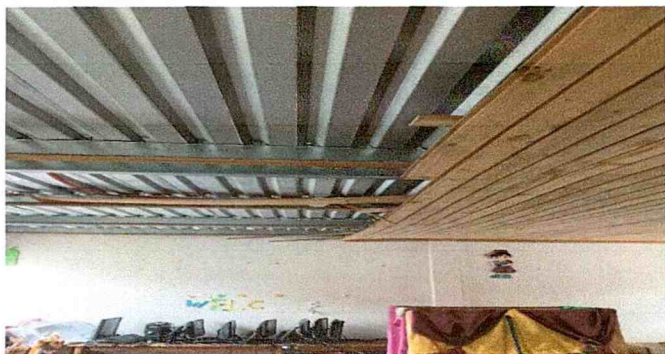
Foto 13: Sustitución de cielo falso por cielo de PVC
