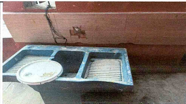
Foto 18: Sustitución de lavamanos por lavamanos empotrados incluye azulejo
