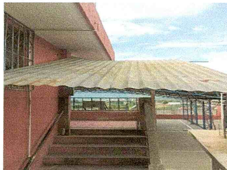
Foto 2: Sustrución de lámina troquelada calibre 26 incluye
