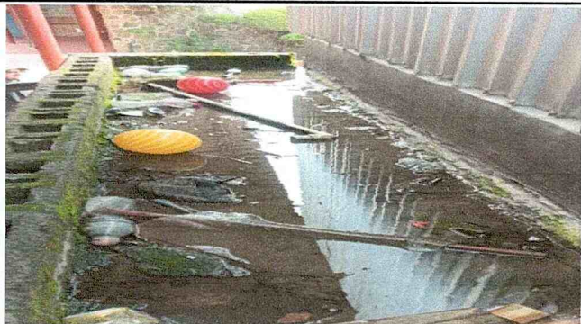
Foto 3: Mantenimiento correctivo en pañuelos en terraza lateral
