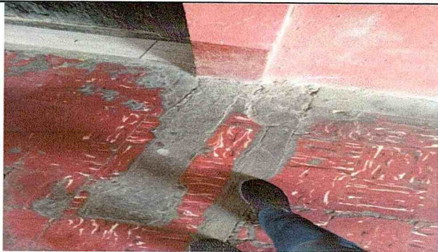
Foto 5: Sustrución de piso, por piso cerámico formato 33.33 cms
