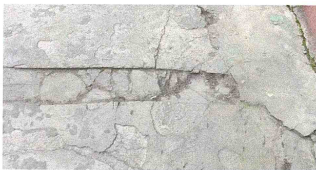
Foto 9: Mantenimiento en piso de concreto en bodega
