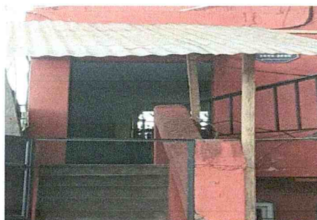
Foto 16: Sustitución de lámina troquelada calibre 26
