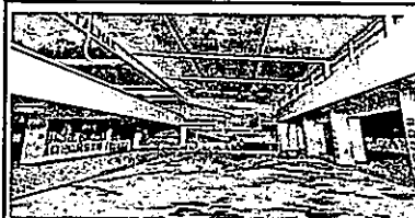
Mantenimiento correctivo en losa con concreto y aditivo para concreto viejo y nuevo con un 2 % de desnivel hacia aguas pluviales y acabado remolineado 168 m2. en patio tercer nivel
