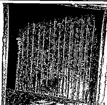
Sustitución de puerta de metal 0.83 m* 2 m en bodega de leña
