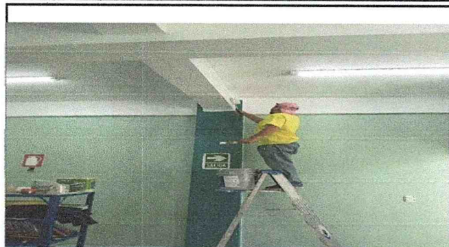
Foto 2: Aplicación y Mantenimiento de pintura en todos los modulos 1,2
