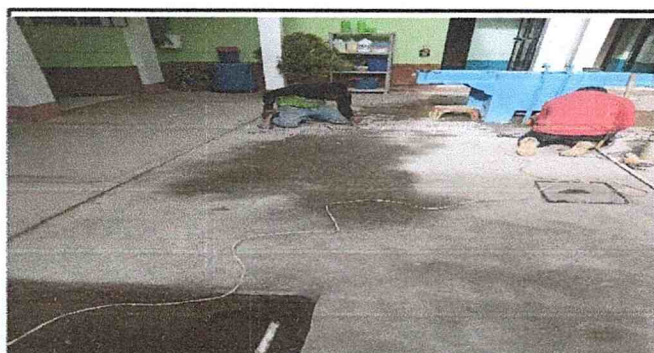
Foto 4: Reparacion de tubería de agua potable en baños de hombres
