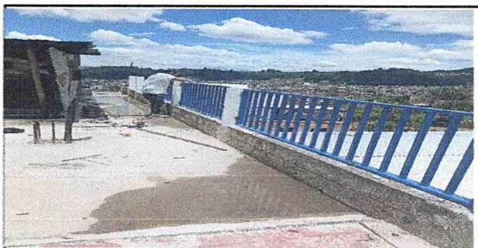
Foto 3: Sustitución de baranda de lámina por baranda de hierro metálico módulo 3
