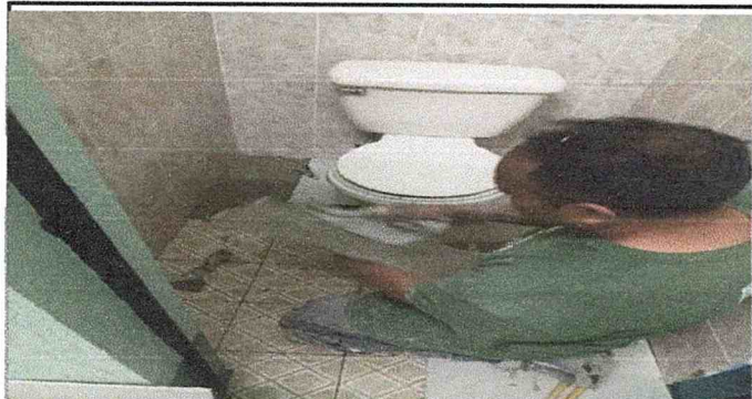
Foto1: Sustitución de piso cerámico por piso porcelanato en módulos de baños.
