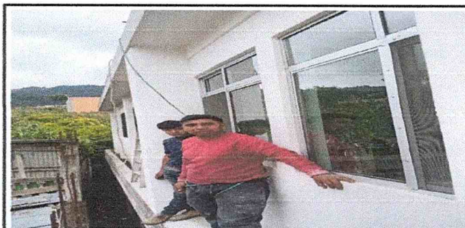
Foto 5: Sustitución de balcón por balcón metálico en módulo 2
