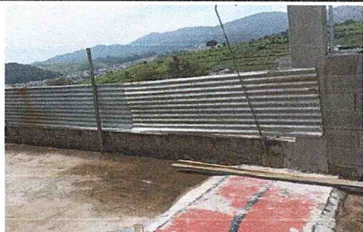
Sustitución de baranda de lámina por baranda de hierro metálico más pintura en módulo 3
