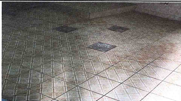
Sustitucion de piso ceramico por piso porcelanato en módulo de baño
