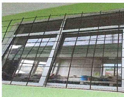
Sustitución de balcon por balcon de metal en módulo 2
