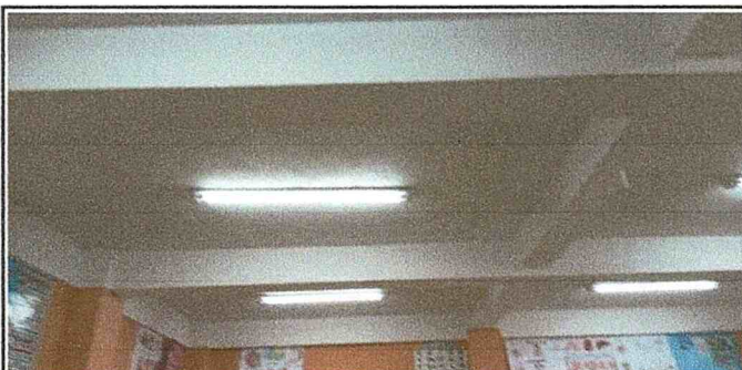
Sustitución de lamparas flourecentes 200-RS-48-2/FIT Lampara 2*48 RS Liston con 2 tubos flourecente18w DL
