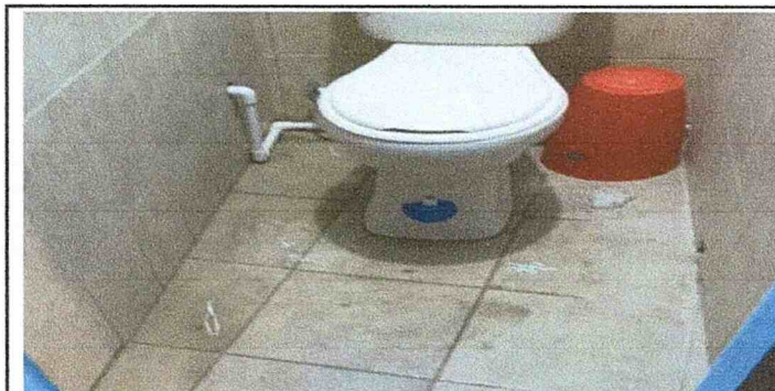
Sustitución de accesorios de inodoro
