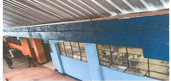
Impermeabilización de losa con impermeabilizante acrílico 6 años
