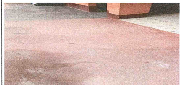
Reparación de banquetas de concreto
