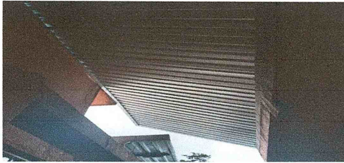
Sustitución de lámina por lámina troquelada calibre 26
