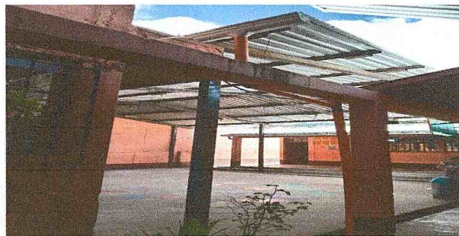
Sustitución de bajada de agua pluvial tubo PVC
