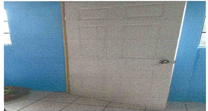
Suministro E instalacion de puerta de madera parte interior con chapa de bola
