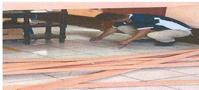
Remozamiento de estructura de pared de tabla yeso de interior de aulas
