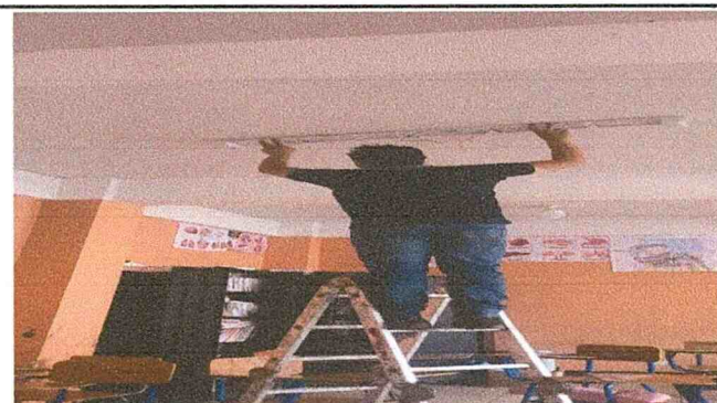
Sustitución de lamparas flourecntes 200-RS-48-2/FIT Lampara 2*48 RS Liston con 2 tubos flourecnte18w DL
