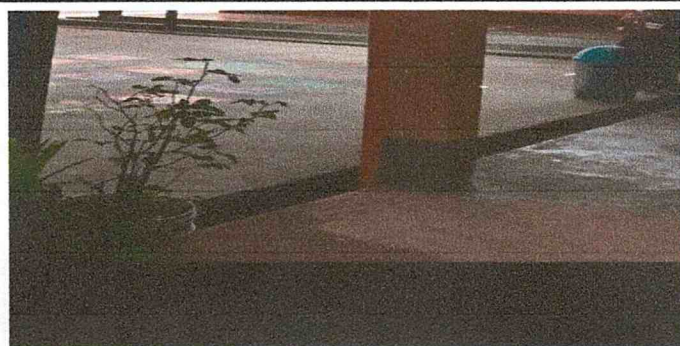
Reparación de banquetas de concreto
