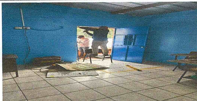
Sustitución de puertas de metal incluye chapa yale
