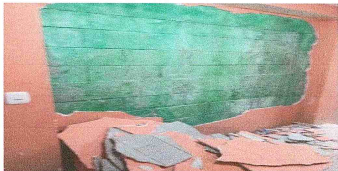
Suministro y aplicación pintura interior latex lavable color celeste pantone 293 y zocalo azul pantone 293 (limpieza, resane y aplicación)
