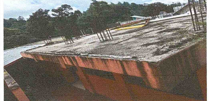
Impermeabilización de losa con impermeabilizante acrílico 6 años
