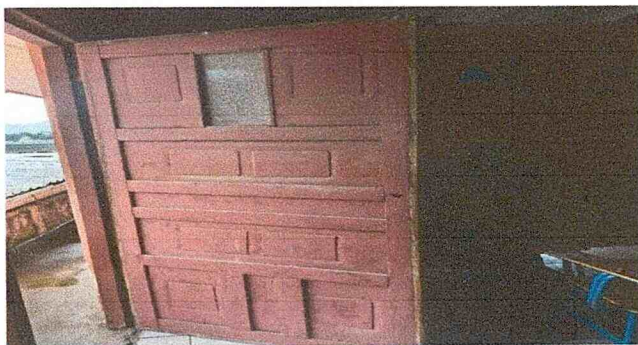
Sustitución de puertas de metal incluye chapa yale
