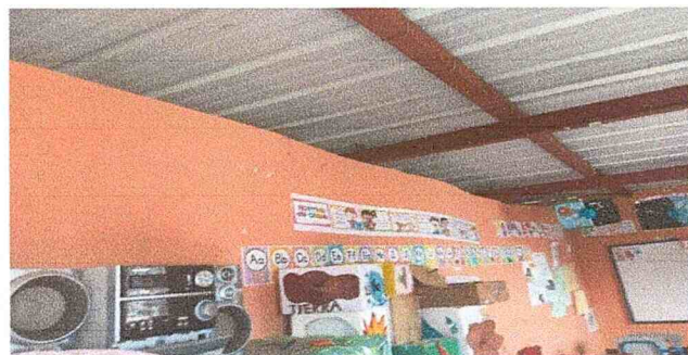
Remozamiento de estructura de pared de tabla yeso de interior de aulas
