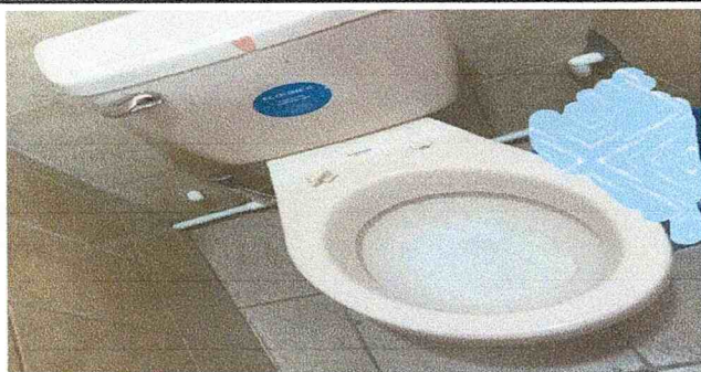
Sustitución de accesorios de inodoro
