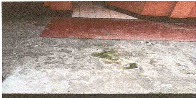
Reparación de banquetas de concreto
