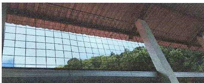
MANTENIMIENTO CORRECTIVO DE ESTRUCTURA CON ELECTRO MALLA PERIMETRO DE CANCHA, FINALIZADO
