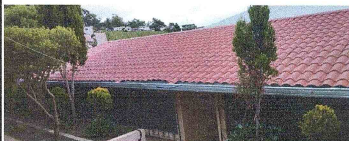
SUSTITUCIÓN DE LAMINA, POR LAMINA ARQUITEJA ROJA CALIBRE 26 Y ACCESORIOS. FINALIZADO TODO EL PROCESO.
