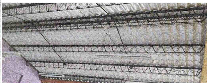
MANTENIMIENTO DE ESTRUCTURA DE SOPORTE DE METAL CON ANTICORROSIVO, CONCLUIDO
