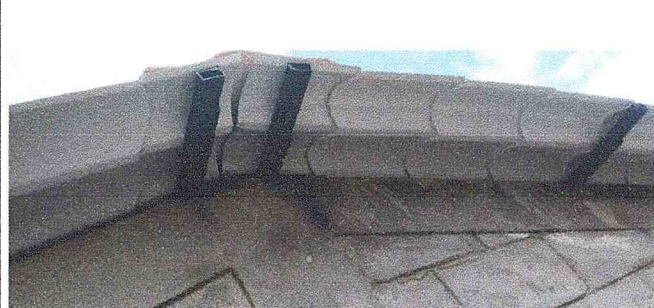
SUSTITUCION DE LAMINA POR LAMINA ARQUITEJA ROJA CALIBRE 26 Y ACCESORIOS. FASE FINAL, CONCLUIDO.-
