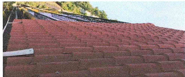
SUSTITUCION DE LAMINA POR LAMINA ARQUITEJA ROJA CALIBRE 26 Y ACCESORIOS, FASE DE COLOCACIÓN.-
