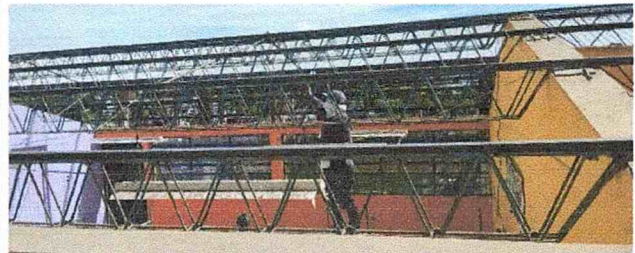
MANTENIMIENTO DE ESTRUCTURA DE SOPORTE DE METAL CON ANTICORROSIVO, FASE INTERMEDIA O EN PROCESO.-
