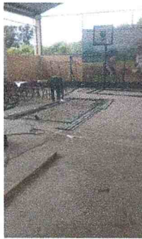
MANTENIMIENTO CORRECTIVO DE ESTRUCTURA CON ELECTRO MALLA PERIMETRO DE CANCHA, FASE INTERMEDIA O EN CURSO.
