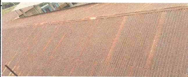
SUSTITUCIÓN DE LAMINA, POR LAMINA ARQUITEJA ROJA, CALIBRE 26, CAPOTE Y TORNILLOS
