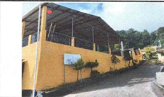
MANTENIMIENTO CORRECTIVO, CAMBIO DE CONEXIONES EN REFLECTORES SISTEMA ELECTRICO EN CANCHA DEPORTIVA.
