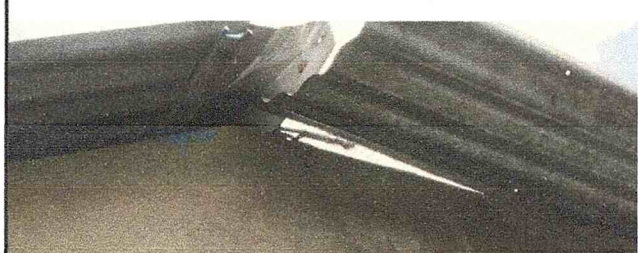
MANTENIMIENTO DE ESTRUCTURA DE SOPORTE DE METAL, COLOCACIÓN DE TUBO 2X1 CALIBRE 16 COMO NIVELADOR, LIJADO Y 2 CAPAS DE PINTURA ANTICORROSIVO.
