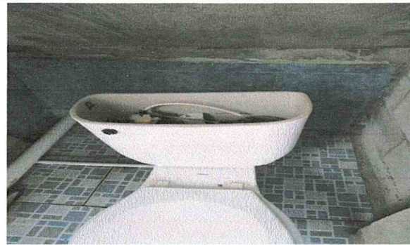
Sustitución de inodoro elongado en baños.
