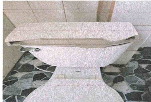
Sustitución de inodoro elongado en baños.
