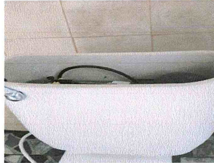
Sustitución de inodoro elongado en baños.
