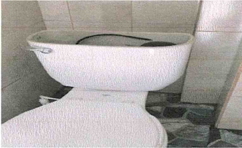
Sustitución de inodoro elongado en baños.
