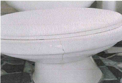
Sustitución de inodoro elongado en baños.
