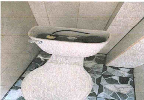
Sustitución de inodoro elongado en baños.
