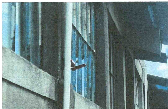
Suministro y aplicación de pintura exterior látex celeste PANTONE293 para muros y azul PANTONE 293 para zócalo
