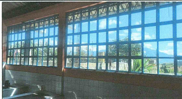
Sustitución de estructura de metal de ventana con vidrio de 5 mm
