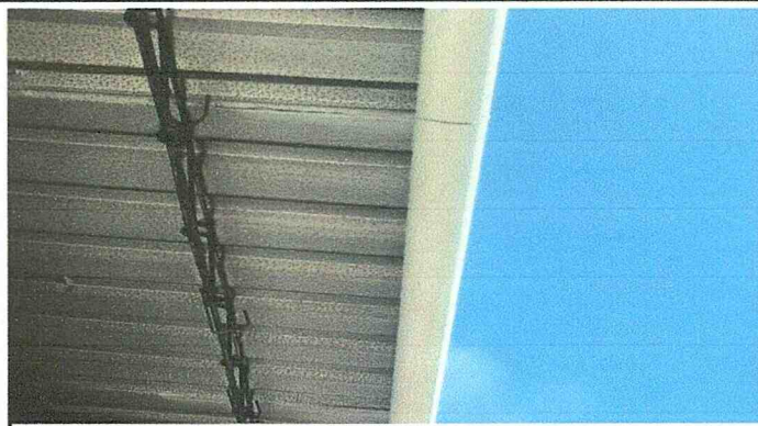
Sustitución de canal de metal
