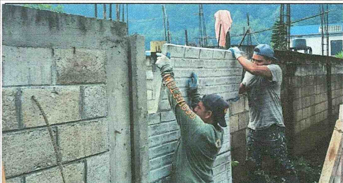
Sustitución de muro perimetral con barda prefabricada de concreto (concreto reforzado)
