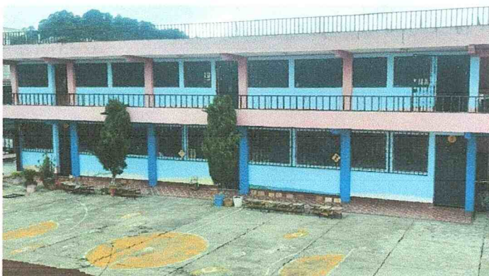
Suministro y aplicación de pintura exterior látex celeste PANTONE293 para muros y azul PANTONE 293 para zócalo
