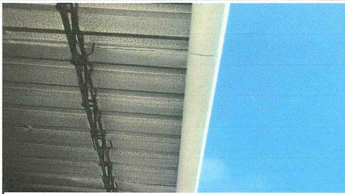
Sustitución de canal de metal
