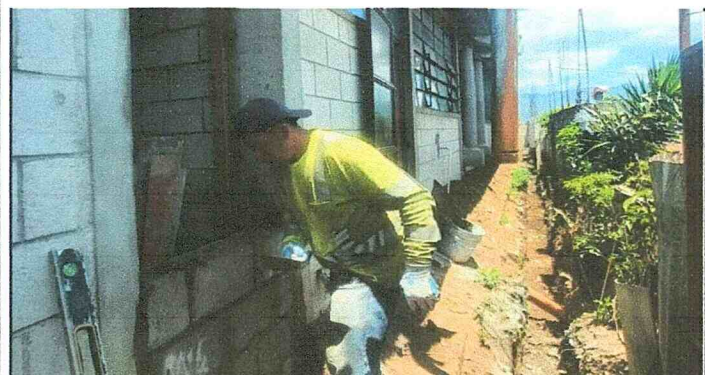
Reparación de muro con block de 14x19x39 cm
