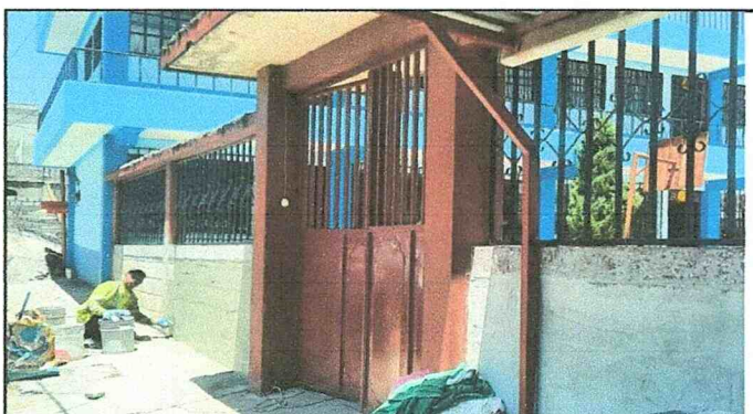
Repello en muro perimetral de ingreso
