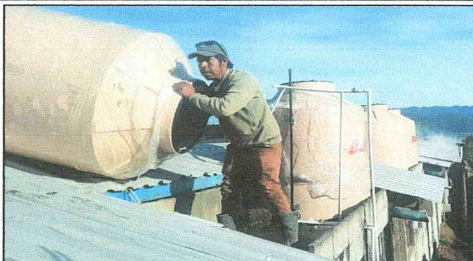
Sustitución de depósito de agua 1100 litros (tricapa)
