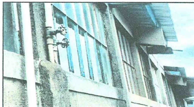
Sustitución de accesorios de depósito de agua
