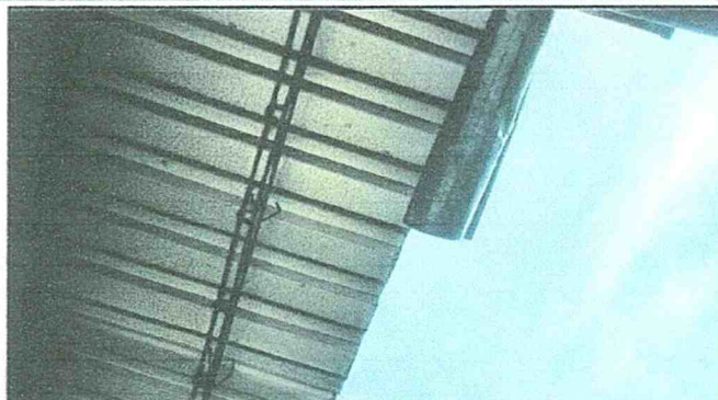
Sustitución de canal de metal
