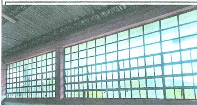
Sustitución de estructura de metal de ventana con vidrio de 5 mm
