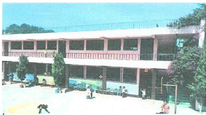
Suministro y aplicación de pintura exterior látex celeste PANTONE293 para muros y azul PANTONE 293 para zócalo
