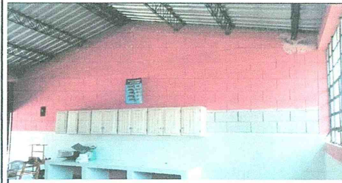
Suministro y aplicación de pintura interior látex lavable
