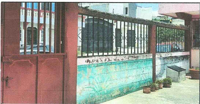
Alisado en muro perimetral de ingreso
