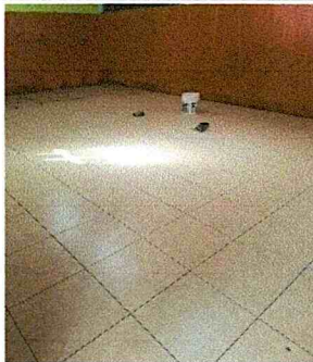
Aula Segundo "A" Mantenimiento sustitucion de piso a piso ceramico. 42 mts. 2
