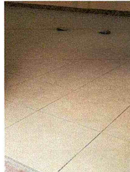
Aula Sexto "B" Mantenimiento sustitucion de piso a piso ceramico. 52 mts.2
