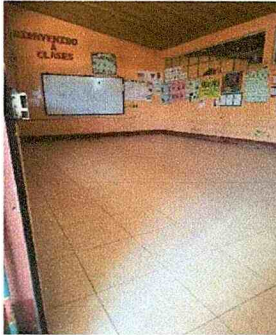
Aula Cuarto sección "A" Mantenimiento sustitucion de piso a piso ceramico. 42 mts. 2
