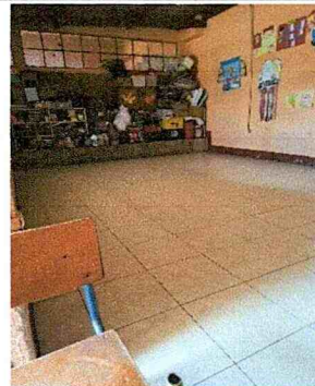
Parvulos "A" Mantenimiento sustitucion de piso a piso ceramico, 40mts.2 y nivelación porque el piso anterior no esta nivelada.
