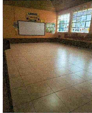
Aula Parvulos sección "B" Mantenimiento sustitucion de piso a piso ceramico. 42 mts.2
