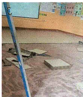
Aula Cuarto sección "A" Mantenimiento sustitucion de piso a piso ceramico. 42 mts. 2
