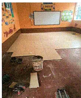
Aula Segundo "A" Mantenimiento sustitucion de piso a piso ceramico. 42 mts. 2
