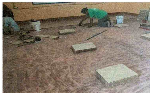
Aula Parvulos sección "B" Mantenimiento sustitucion de piso a piso ceramico. 42 mts.2
