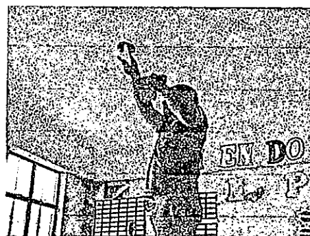
unidad de Sustitución de lámparas de barra por plafonera y foco led DE 50 WATS incluye plafoneras
