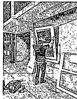
metros cuadrados de Sustitución de ventana de metal por ventana de PVC corrediza en cocina
