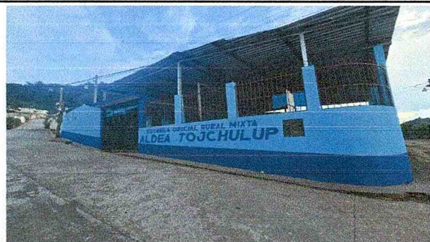
Suministro y aplicación Pintura exterior látex celeste Pantone 293 para muros
