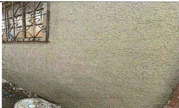
Repello en muro exterior
