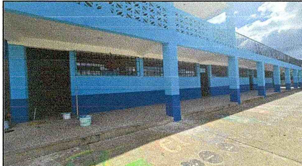
Suministro y aplicación Pintura exterior látex Azul Pantone 293 para zócalo 4 hiladas
