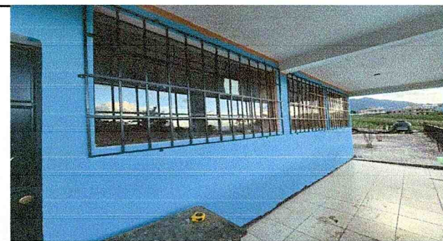
Sustitución de balcones
