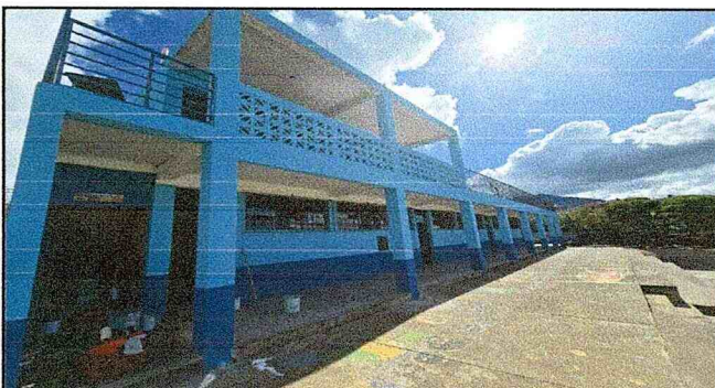
Suministro y aplicación Pintura interior látex lavable (limpieza, resane y aplicación)
