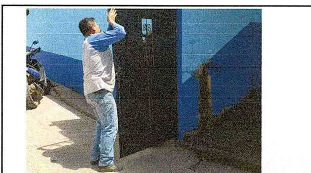
Mantenimiento a portones de metal (lijado, pintado, y cambio de partes de perfiles dañados)
