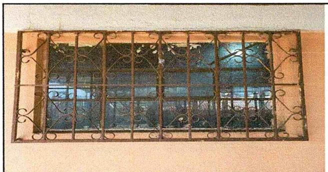
Sustitución de balcones
