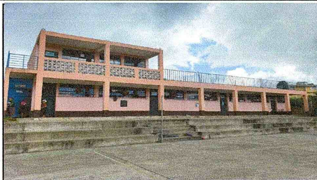
Suministro y aplicación Pintura exterior látex Azul Pantone 293 para zócalo 4 hiladas
