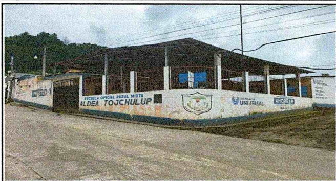
Suministro y aplicación Pintura exterior látex celeste Pantone 293 para muros
