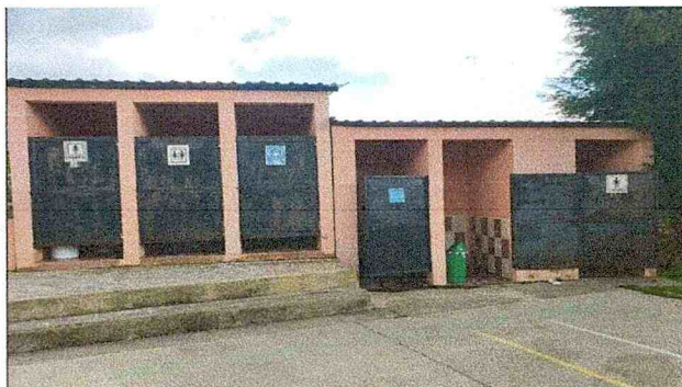
Suministro y aplicación pintura lavable antimicrobial para sanitarios lavable (limpieza, resane y aplicación)
